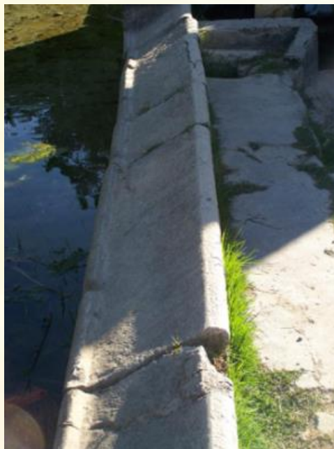
Lavadero 1, detalle de las piedras de lavar.
