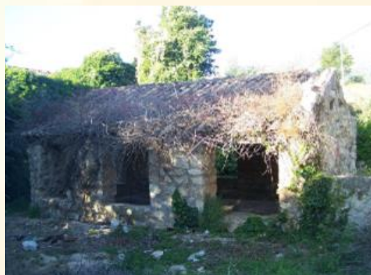
Lavadero de la zona inferior (Lavadero 2)
