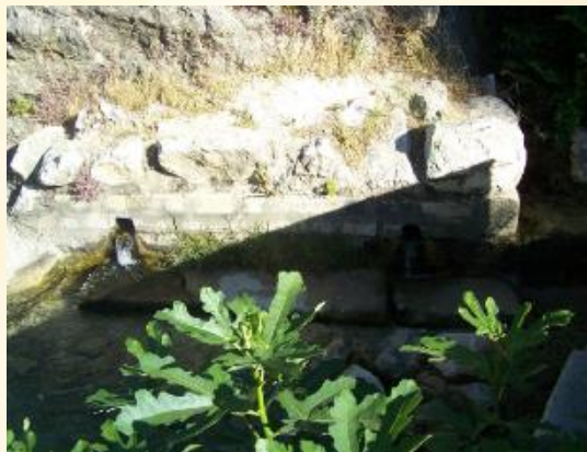
Fuente que abastece el Lavadero 1
