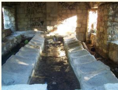
Interior del lavadero 2
