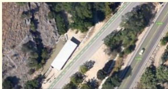
Lavadero próximo al manantial
