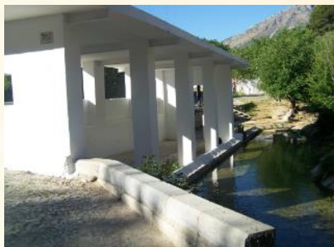
Lavadero 1. Estanque y piedras de lavar.
