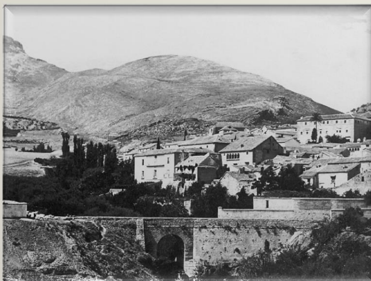
Puente de la Alcantarilla, 1862
