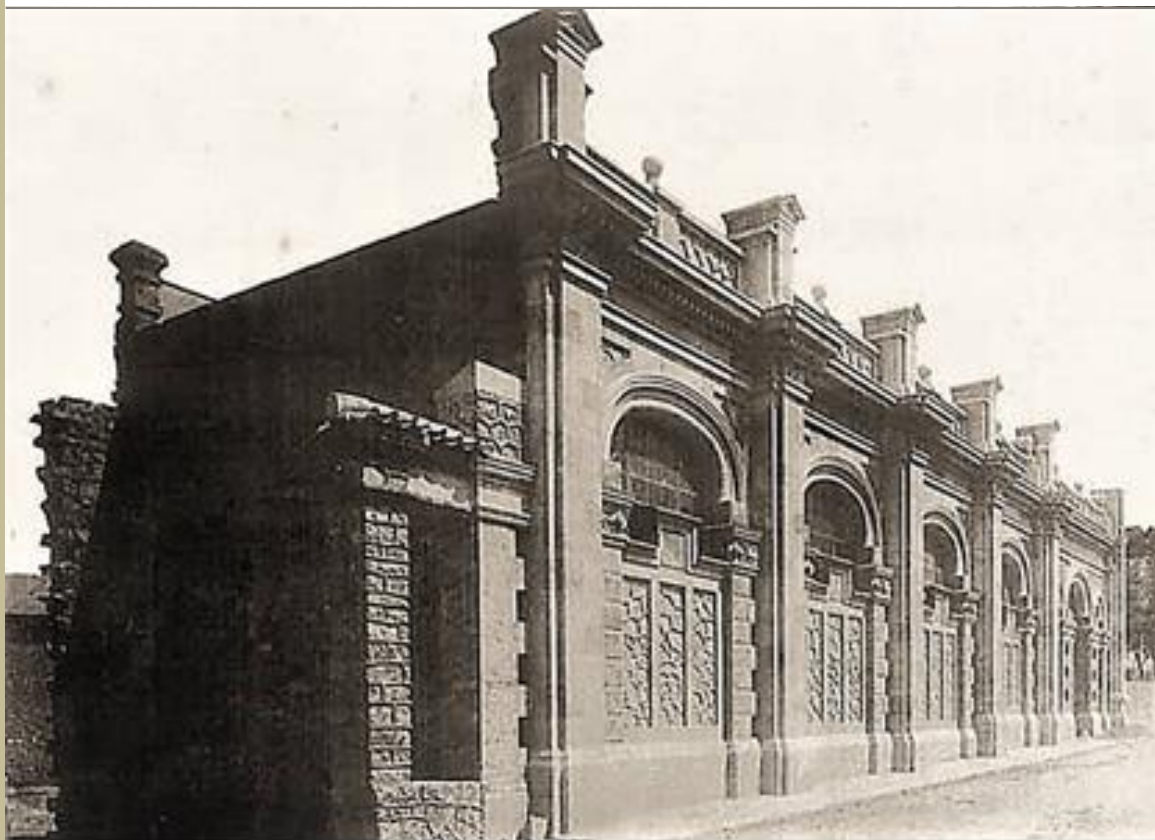
Fachada de la fábrica de perfumes FLORFE.
